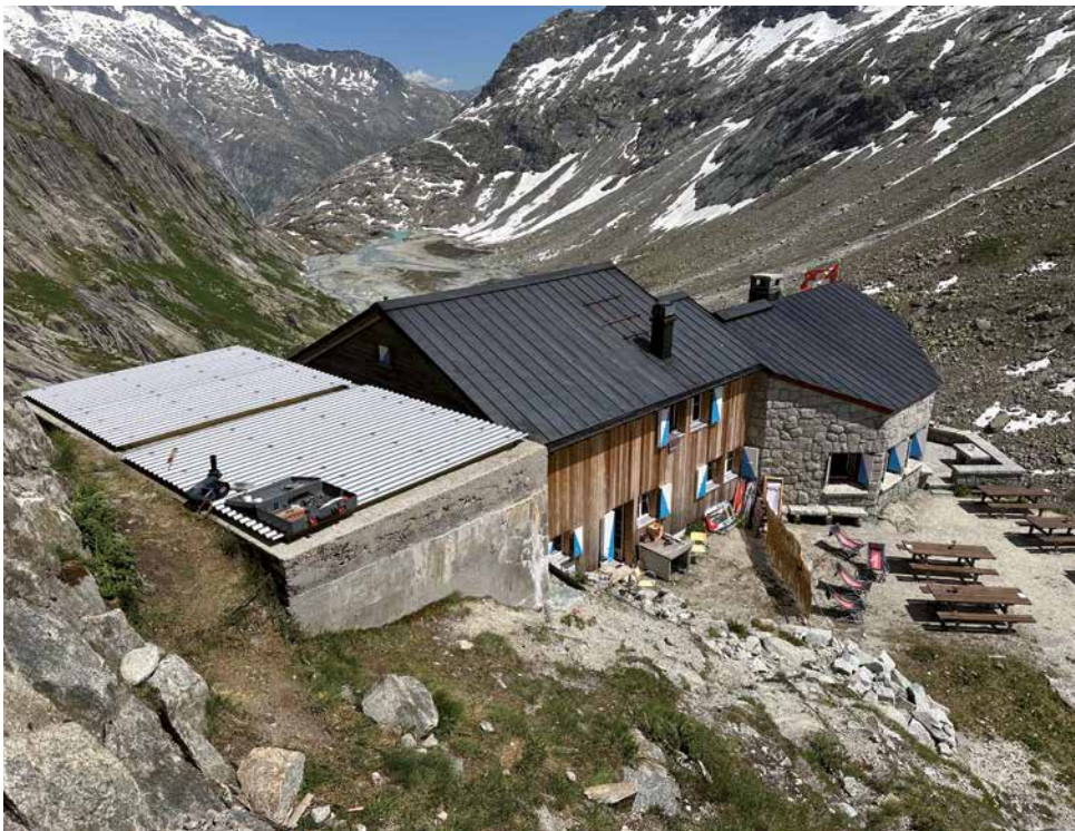
↓ Richtig hübsch, die neue Reservoir Abdeckung
